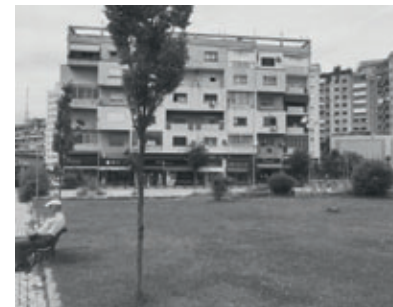
Figure 3. Façade vers la ville. L'appartement de Kadaré est au deuxième étage, au centre. © Project Team.
