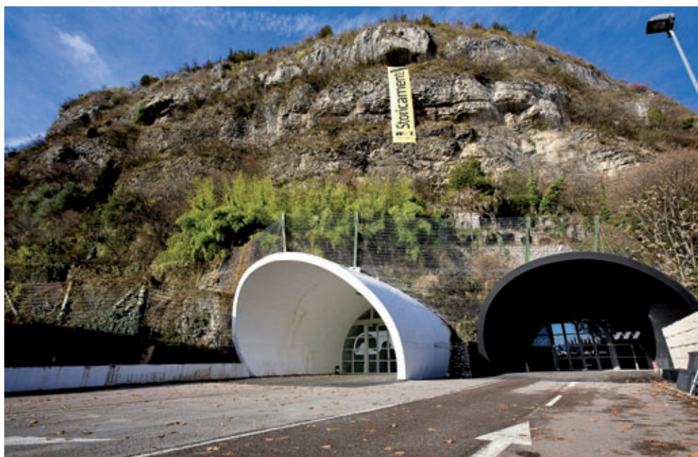
Ingresso al Tunnel autostradale di Trento
